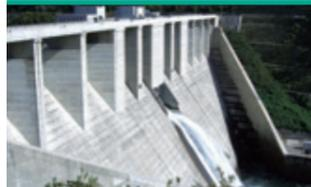
2005年3月に完成した重力式コンクリートダムで、高さは74m、長さ225m、総貯水容量は8,410万m<sup>3</sup>で、岡山県内では3番目の貯水量を誇る、国内で初のラビリンス型(ジグザグ形)の非常用洪水吐を備えた美しいフォルムのダムを案内人と一緒に巡る特別なツアーです。
